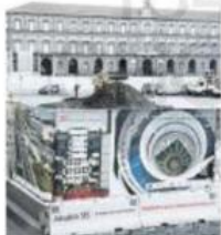
Il cantiere per la Linea 6 del metrò al Plebiscito
