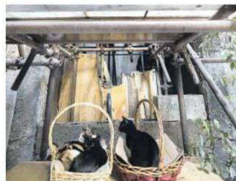
LA VERGOGNA Vicolo Tarallari, il palazzo pericolante puntellato da tubi corrosi dal tempo (40 anni) e i gattini allevati per tenere lontani i topi. A sinistra vicolo Piscicelli, tracce medievali. Nella foto piccola al centro il portale ligneo originale della chiesa di Sant'Agrippino, raffigurato negli intarsi con San Gennaro
